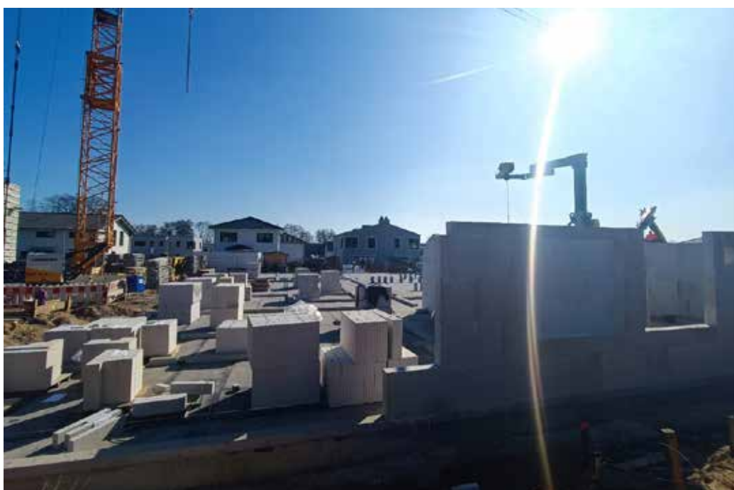
Der Baubeginn für den 2. Bauabschnitt erfolgte Anfang Februar. Die erste Stadtvilla befindet sich bereits in der Hochbauphase. Foto: S. Sperlich
